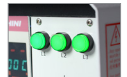
Phasenanzeige zur Kontrolle der Leistungsversorgung
